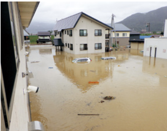
北信署庁舎周辺の浸水被害状況
