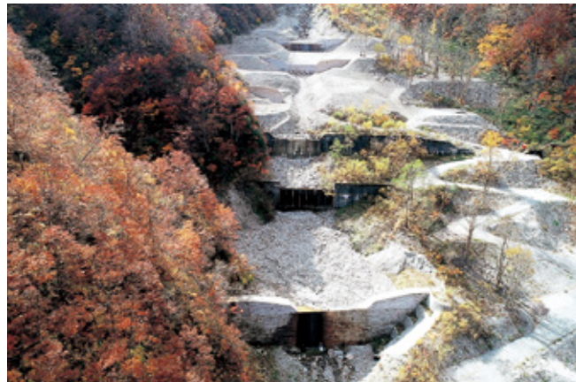
床固工等の施工地（ドローン空撮）
