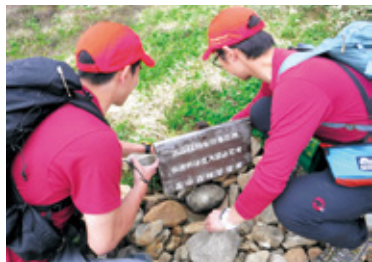
注意看板の補修作業の様子
