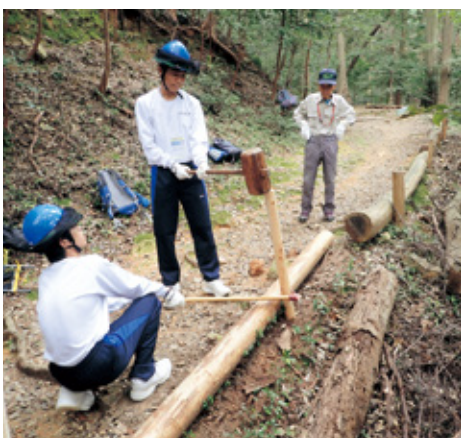
登山道整備のくい打ち作業の様子
