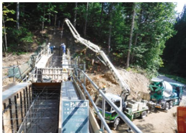
残存型枠による谷止工の様子
