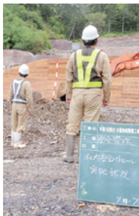
安全パトロールの状況
