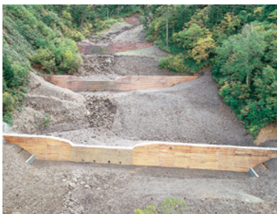
完成した堰堤（最下流）
