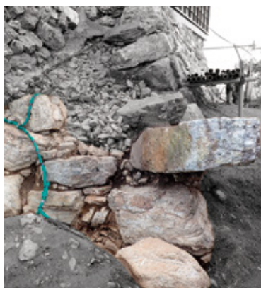
今回発見された信長期に積まれたとされる石垣
