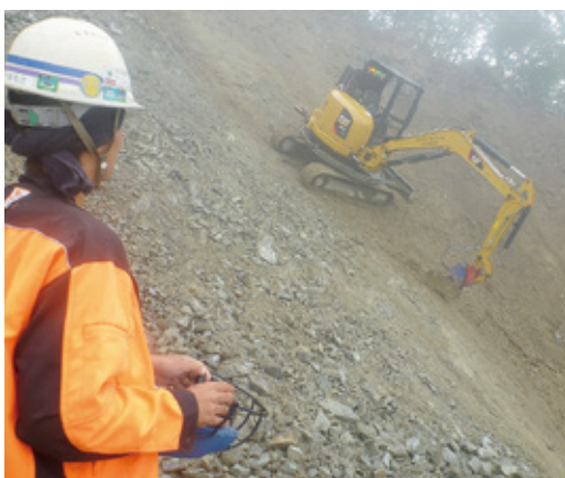
ロッククライミングマシンによる掘削の様子
