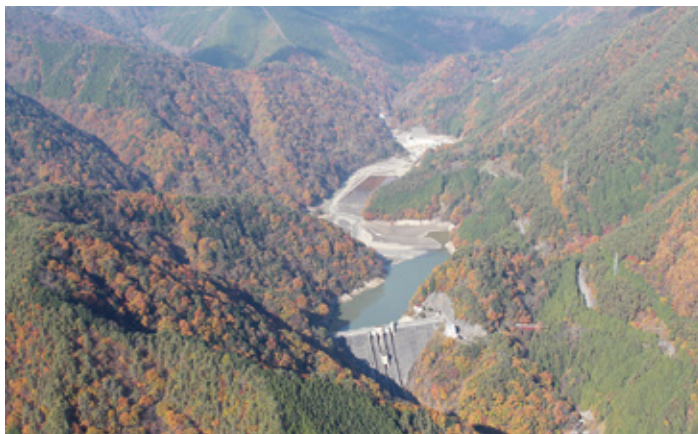
県営松川ダム
