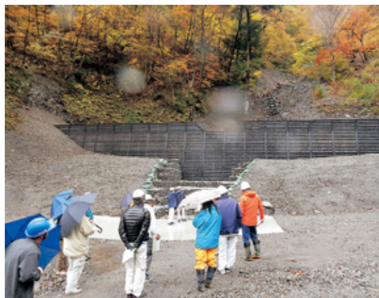
鋼製柱谷止（海ノ溝谷区域）を視察
