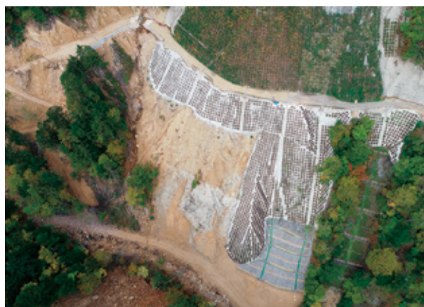
施工七年目の「大ツゲ谷復旧治山工事」現場の様子
