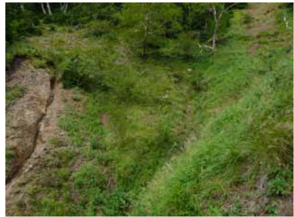
写真 4-195 食害被害地の全景
