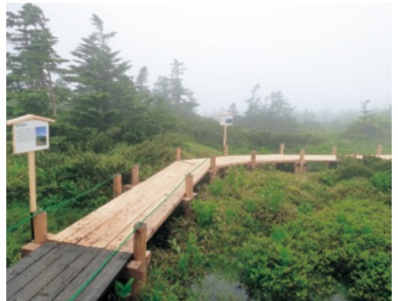
補修された遊歩道
