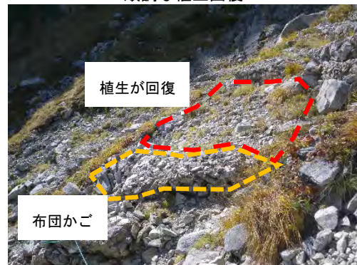
風背地のため表土の流れが止まれば 植生が他所より速く回復する (八丁坂の布団かごの例)
