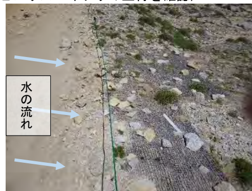
マットの敷設により土砂の流れを せき止め、下側の植生が回復 （天狗荘周辺）
