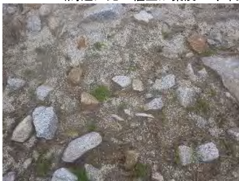
マットはほぐれているが、 土砂の動きが止まり植生が回復 （乗越浄土）
