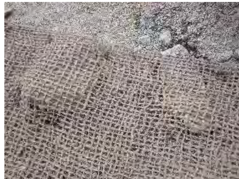
極楽平周辺のマット (大きな石の上に敷設)
