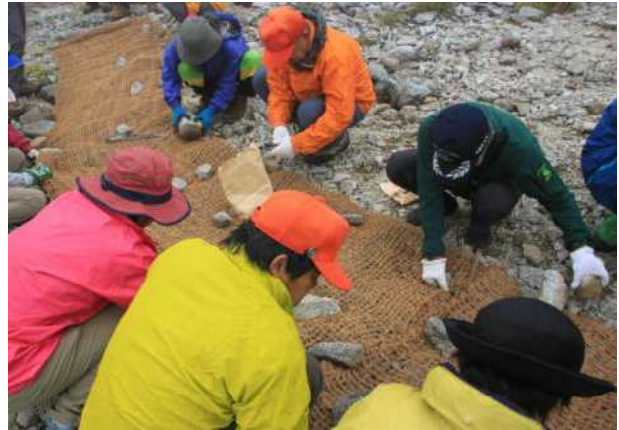
マット敷設作業
