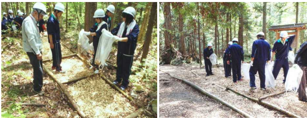
遊歩道へのチップ敷き作業の様子
