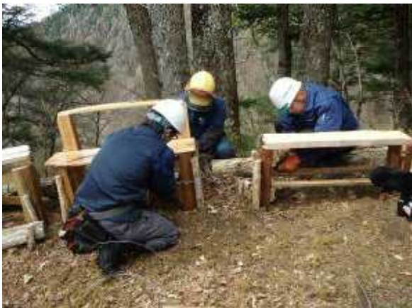
ベンチ設置作業
