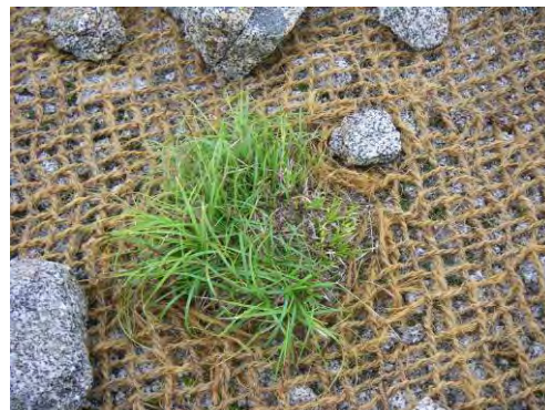
平成 22 年度マット敷設箇所(前岳 2) 地表面を覆うことで落下した種子を保持する
