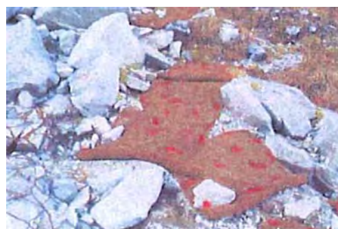
試験的にマットを敷設した状態 (八丁坂 平成 20 年)
