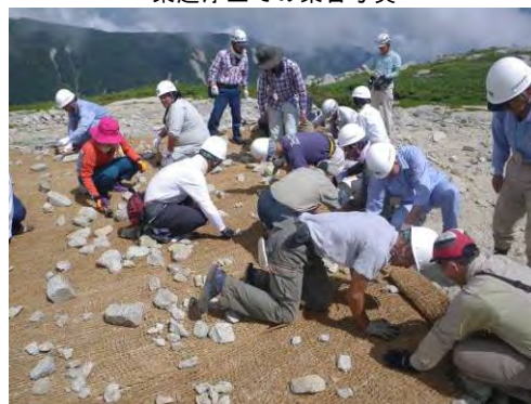
マットの敷設
