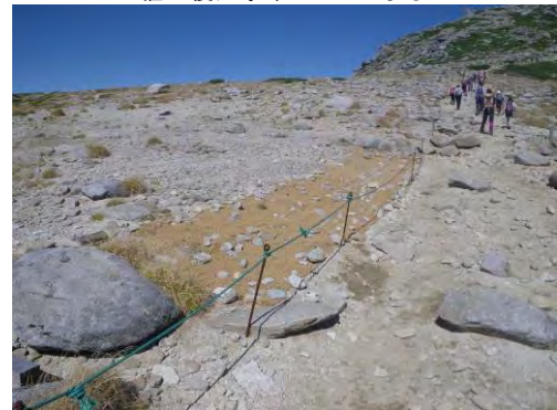
当年度マット敷設箇所(天狗荘北西) ロープと併設することで立ち入り抑制の 視覚的效果は大きい
