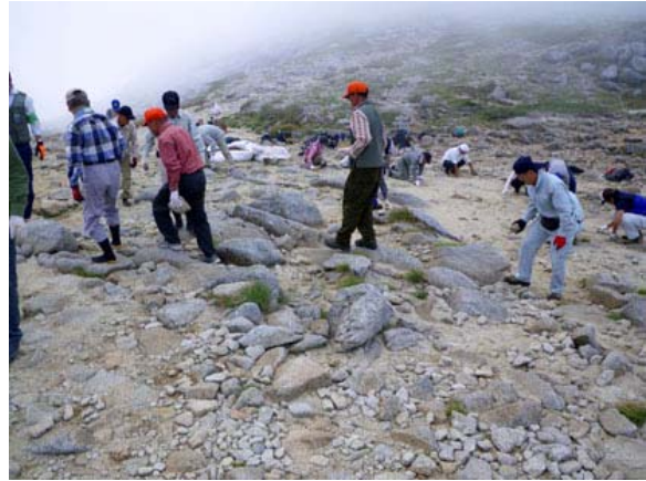
整地作業の状況
