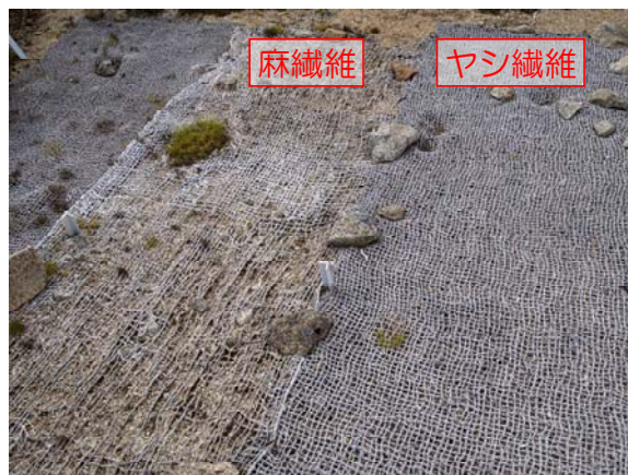
麻繊維とヤシ繊維の状況 (施工3年目・八合目)
