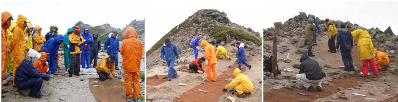
写真Ⅱ-9~11 敷設作業の様子
