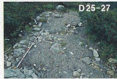
写真Ⅱ-44～55 D地区敷設状況
