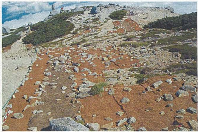
写真Ⅱ-15 敷設終了、左から2枚目が麻繊維マット
