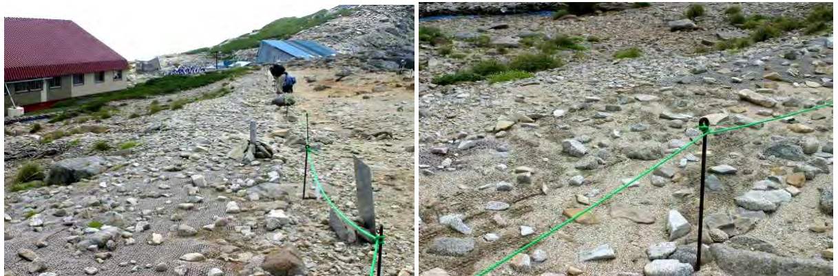
写真 1 平成 17 年施工箇所の状況(右側:流入した土砂が堆積している)
