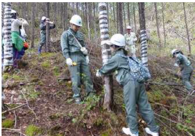
訓練生によるテープ巻作業
