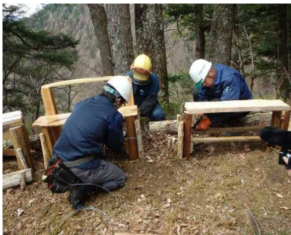
ベンチの設置作業
