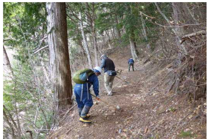
遊歩道の整備
