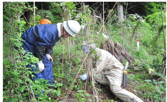
支柱の取替え作業
