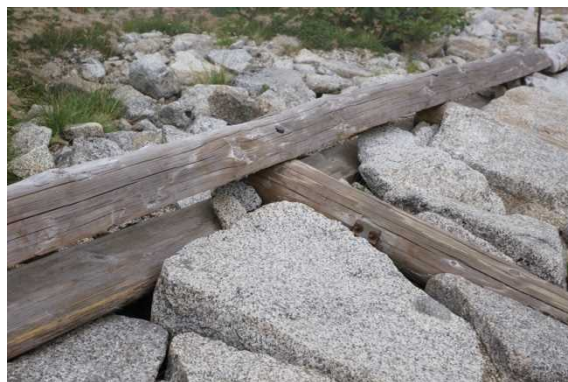
写真2-74 歩道路肩の排水対策
