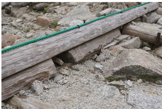
写真2-73 歩道路肩の排水対策
