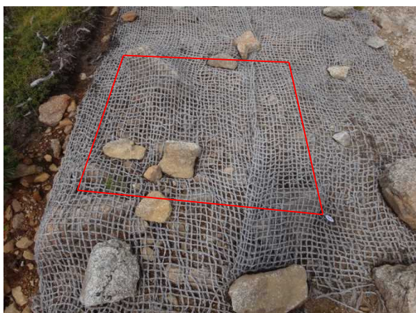
写真2-69 固定枠の整備状況
