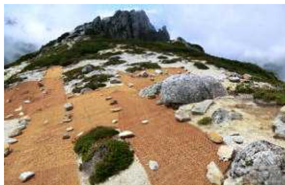
マット敷設後
