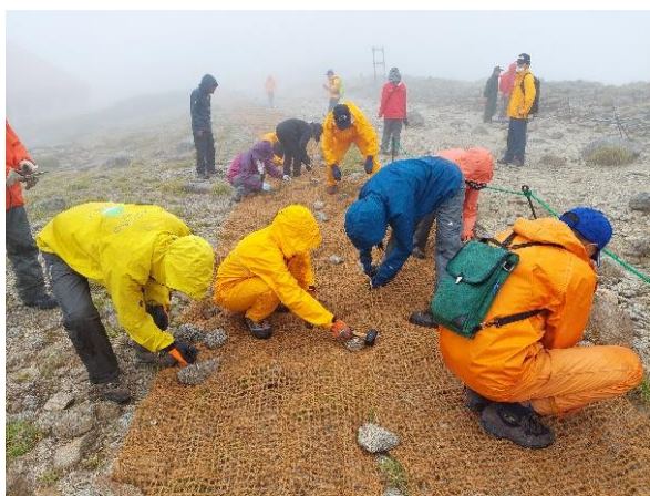
小雨の中での植生マット敷設作業
