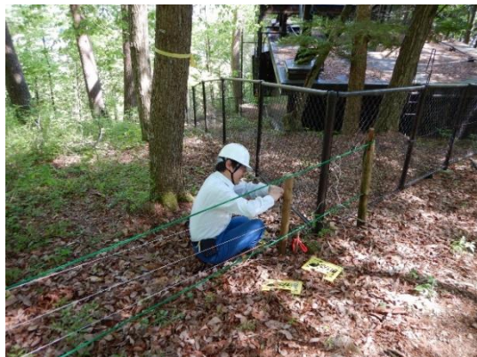
電気柵の設置（5月16日）
