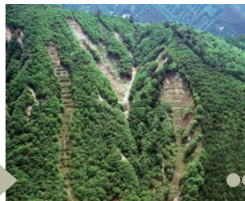
山腹工により斜面が安定 (平成14年)
