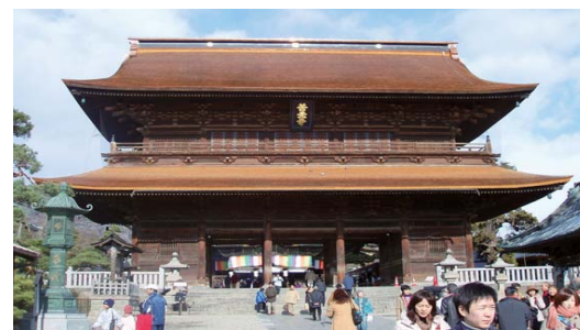
修復工事(屋根の葺替え)が終了した善光寺三門(平成20年) 写真提供/財団法人文化財建造物保存技術協会
