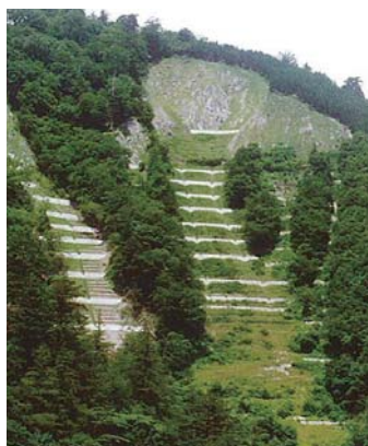
山腹工事により斜面が安定 (平成2年)
