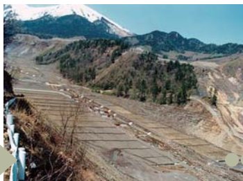
床固工・水路工により溪床が安定 (昭和62年)
