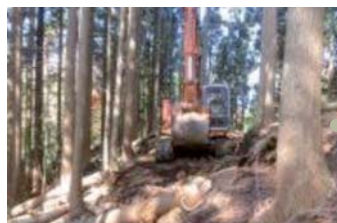
作業路の開設作業
