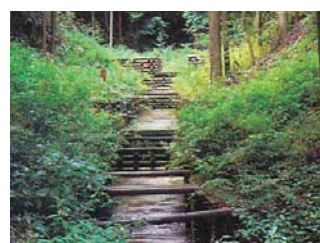
間伐材を使用した床固工・流路工(愛知所)
