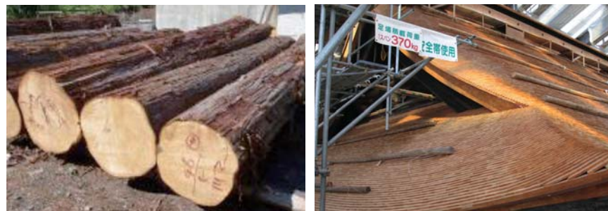
善光寺三門修復工事の資材となった天然サワラ
