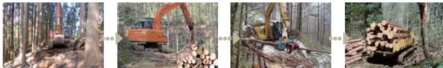
作業路の開設作業
