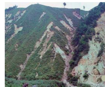
台風などによる荒廃 (平成5年)
