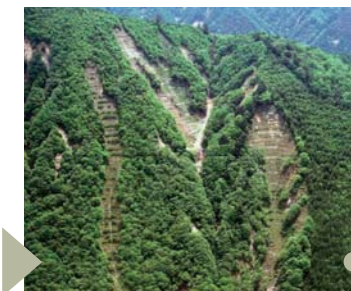
山腹工事により斜面が安定 (平成14年)
