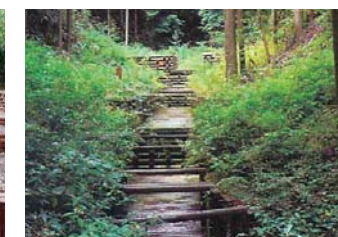
間伐材を使用した床固工・流路工 (愛知所)
