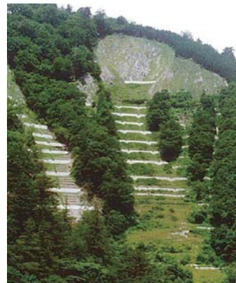
山腹工事により斜面が安定 (平成2年)
