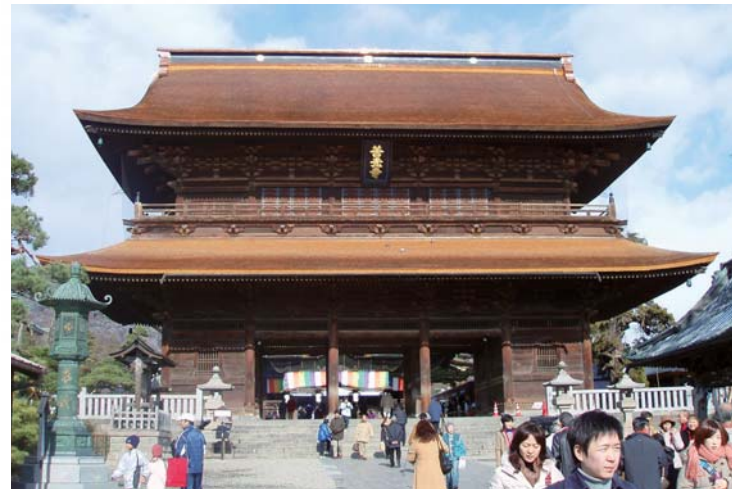
修復工事(屋根の葺替え)が終了した善光寺三門(平成20年) 写真提供/財団法人文化財建造物保存技術協会
