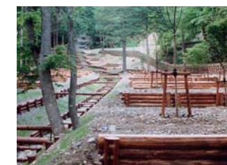
丸太土留工・柵工による山腹工 (東濃署)
