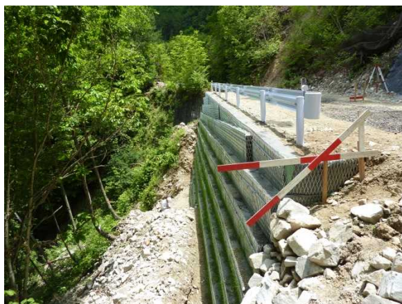
図 8 崩沢支線林道での導入状況
