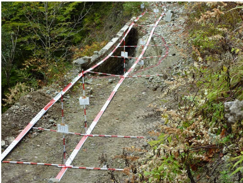
図 4 路体流失状況
