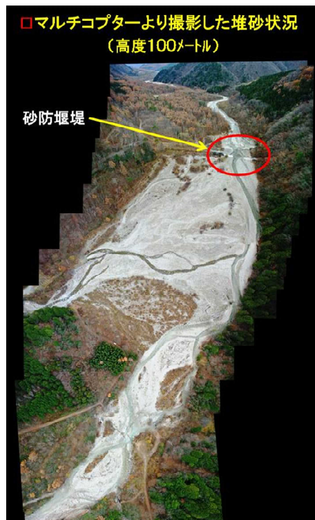
写真-11 堆砂状況
