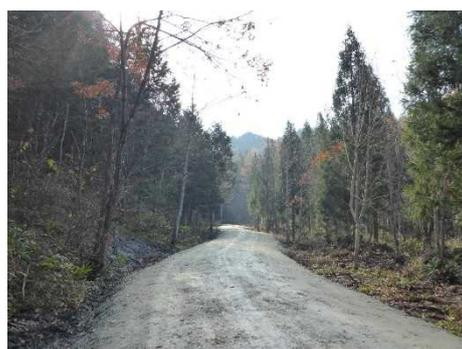
写真-6 屋根型構造の作業道の排水状況
