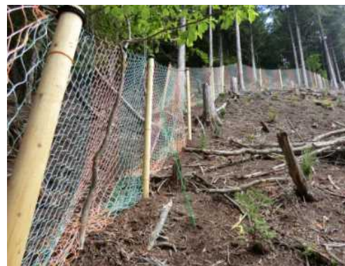
写真-4 設置した防護柵
