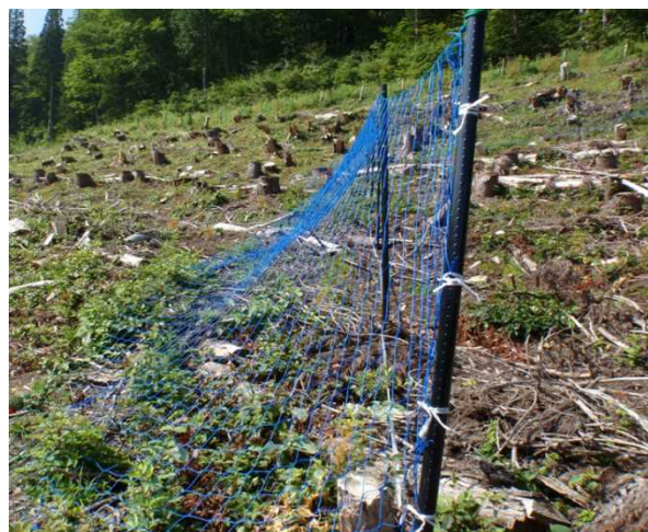
写真-8 斜め張りネット設置状況
