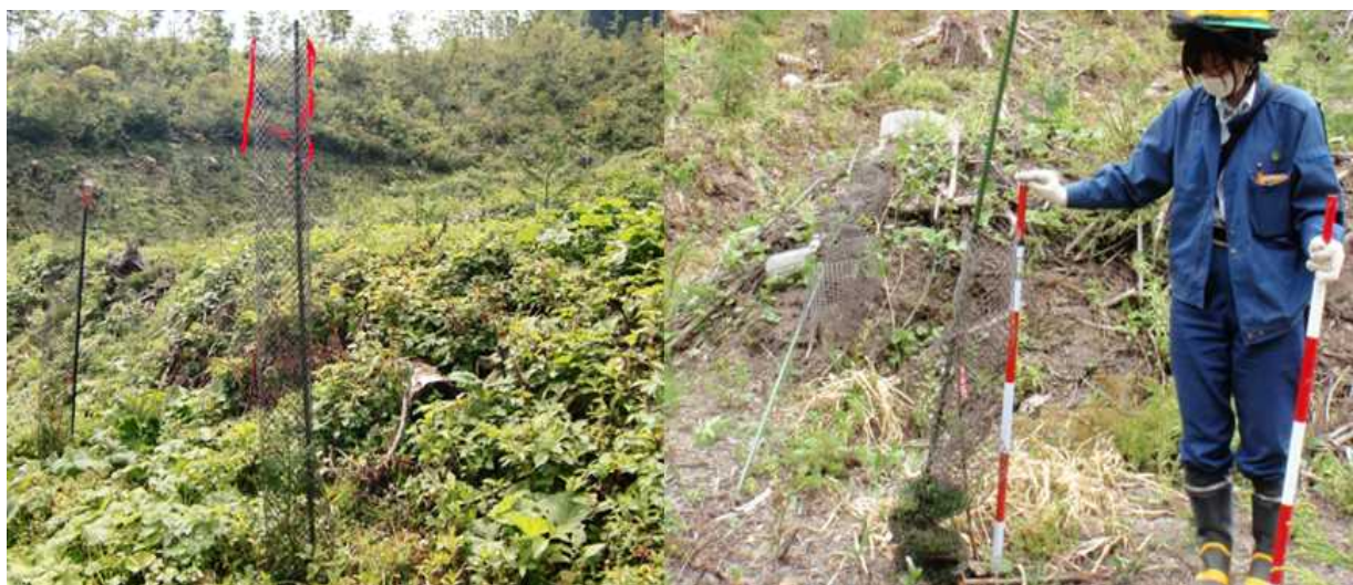
写真-7 サブリガード状況
