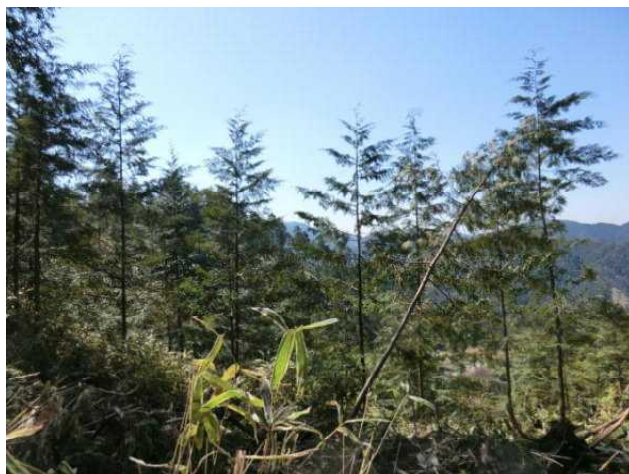
写真－５ 傾斜被害
