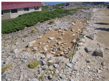
水みち対策の例（マット敷設）
