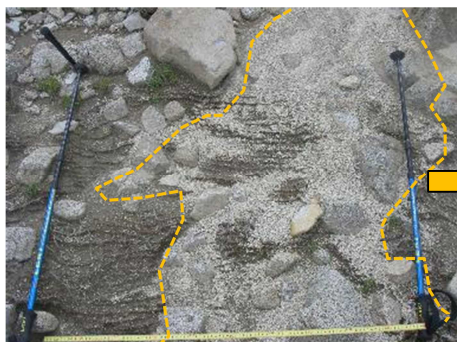
水みち上部にマットを敷設し表土の動きを停止 (天狗荘北西：平成23年)
