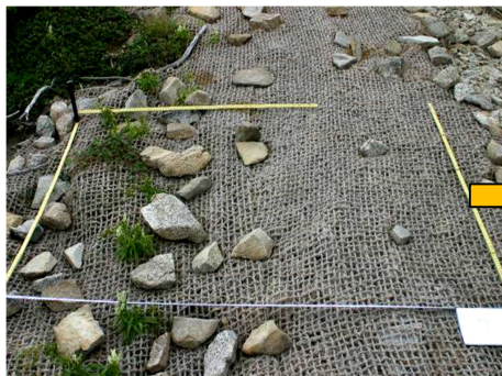
マット敷設直後 (天狗荘北西：平成18年)
