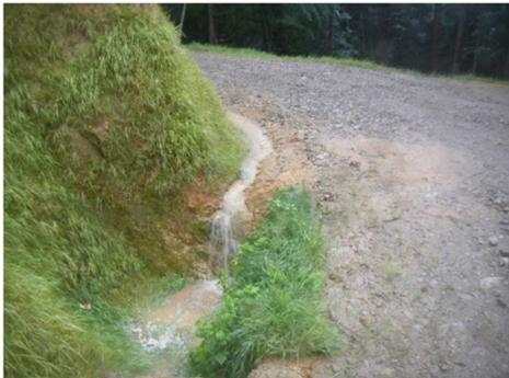
写真-3 素掘り側溝の排水
