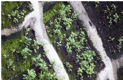
施工後 1 年勾配緩和網設置箇所
