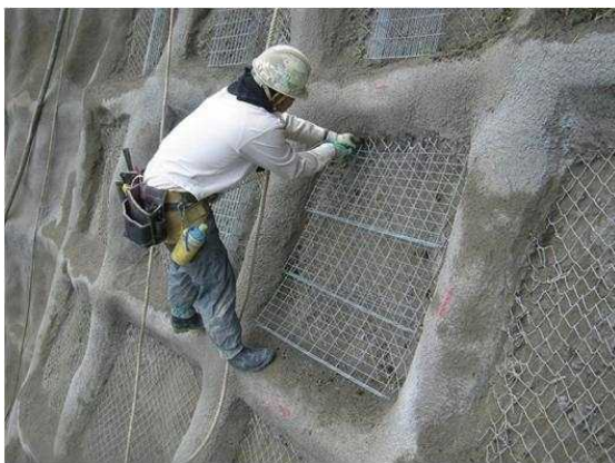
写真 3 勾配緩和網設置状況
