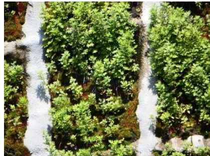
施工後 2 年勾配緩和網設置箇所
