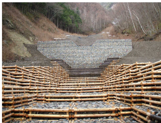
(木製丸太枠水路工)
