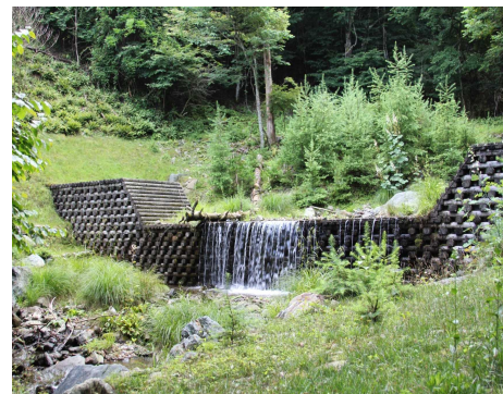
(既設木製治山ダム工・台形型)
