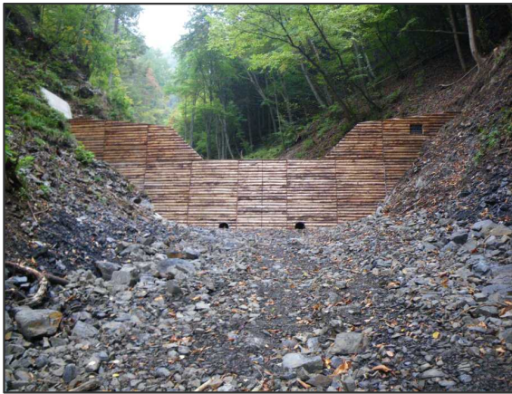
(木製残存型枠を使用した谷止工)
