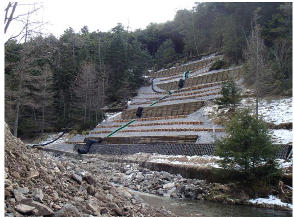
(間伐材を利用した山腹工)
