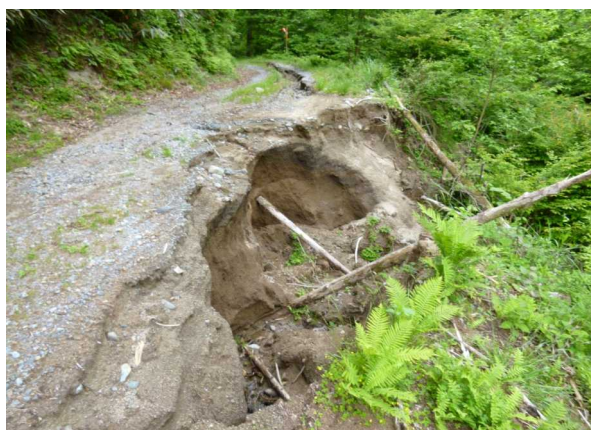
(路肩決壊状況)
