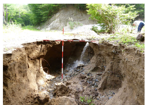
(林道被災状況)
