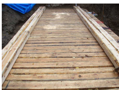
(横木設置状況)
