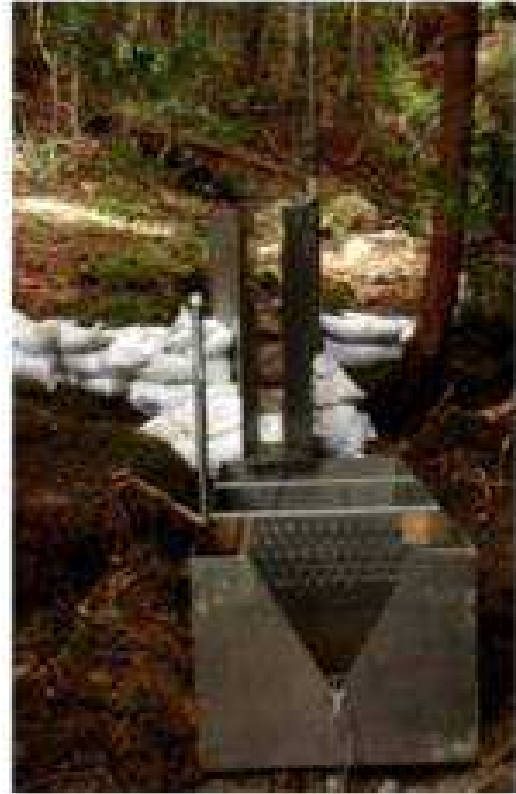
図 6. 河川流量観測機器（三角堰）
