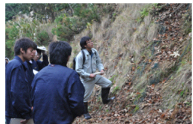
【痕跡調査の講習会の様子】
