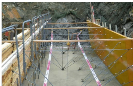
写真-2 型枠の立ち上げ
