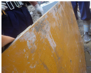
写真-13 脱型後の型枠合板
