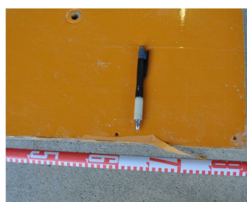
写真-16 塗装面のはがれ
