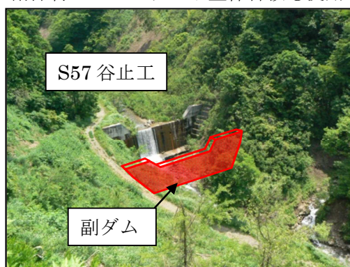
写真-1 治山ダム施工箇所
