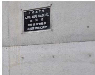
写真-12 打継目の段差
