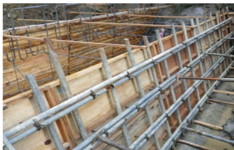
写真-3 単管による支保工
