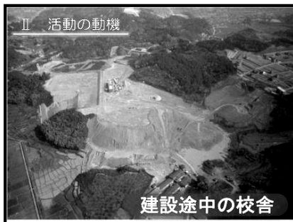
(写真1) 建設途中の様子
