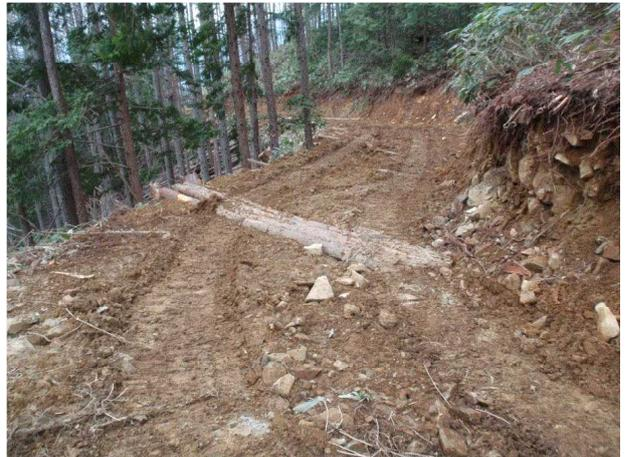
写真1 4 横断工設置状況
