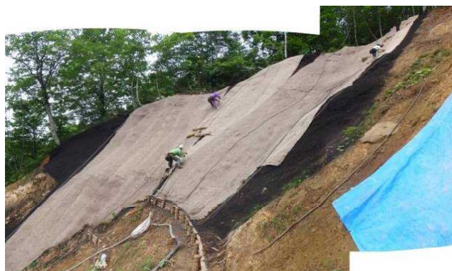
写真4 マット敷設状況
