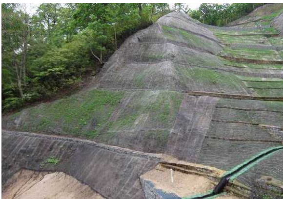
写真5 第1回調査（施工8ヶ月後：5月）
