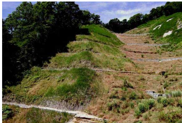
写真8 第4回調査（施工約2年：8月）
