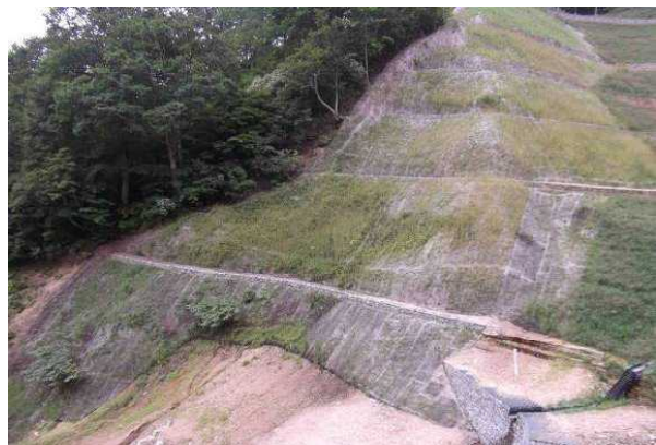
写真6 第2回調査（施工約1年：8月）
