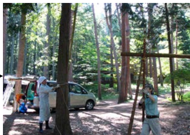
写真6 倒れないように、足をロープで固定します。
