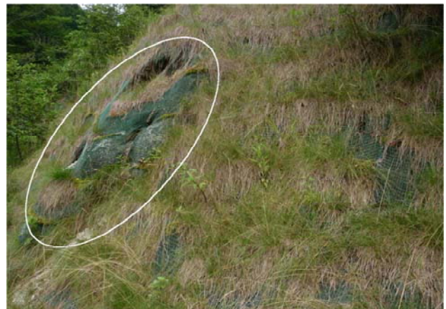
写真-10 土砂が流出した状況（植生シート工）
