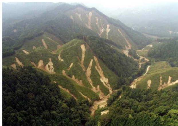
写真-2 平成12年恵南豪雨後の国有林
