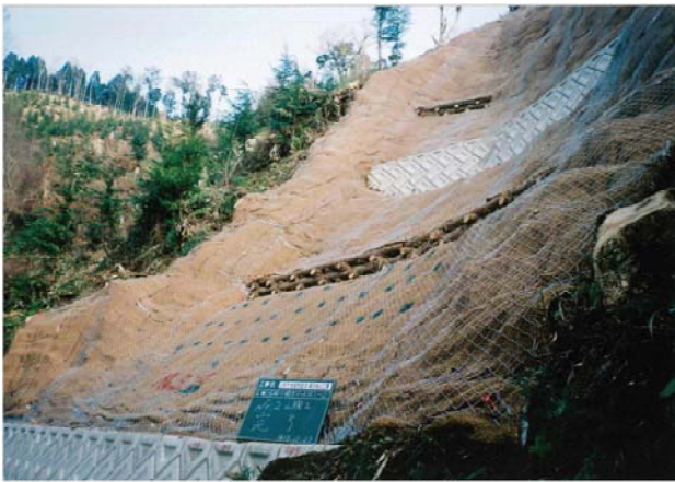
写真-12 金網の併用状況（植生マット伏工）
