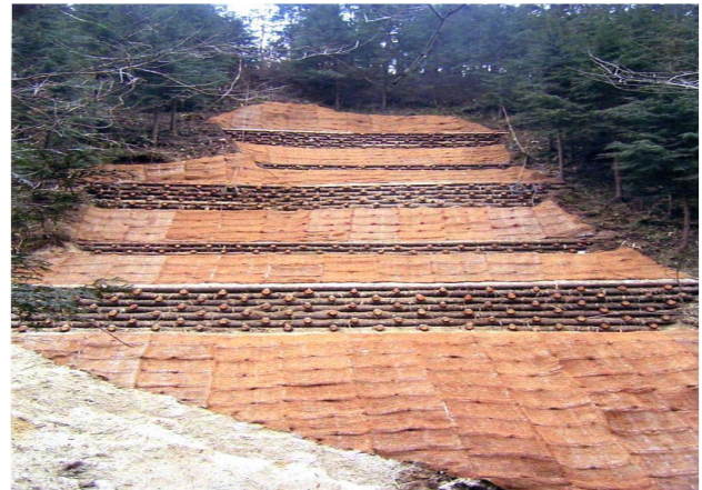
写真-11 施工後の状況（植生マット伏工）
