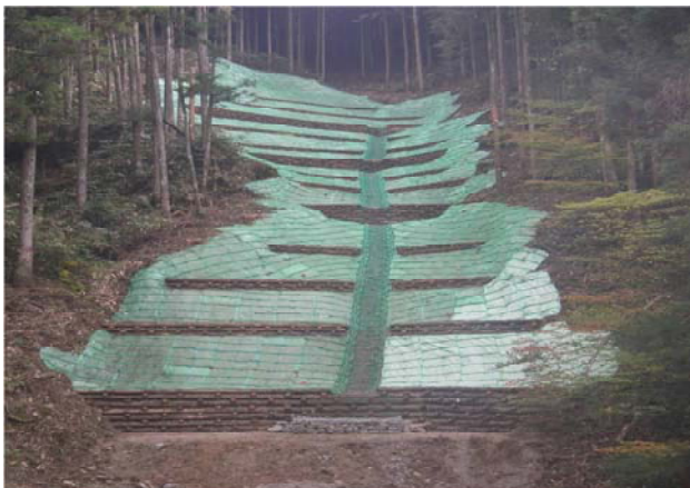
写真-9 施工後の状況（植生シート工）
