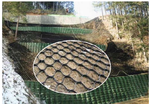
写真-14 ハニカム枠の設置状況 （ハニカム枠厚層基材吹付工）
