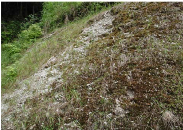
写真-7 発芽不良の箇所（吹付実播工）
