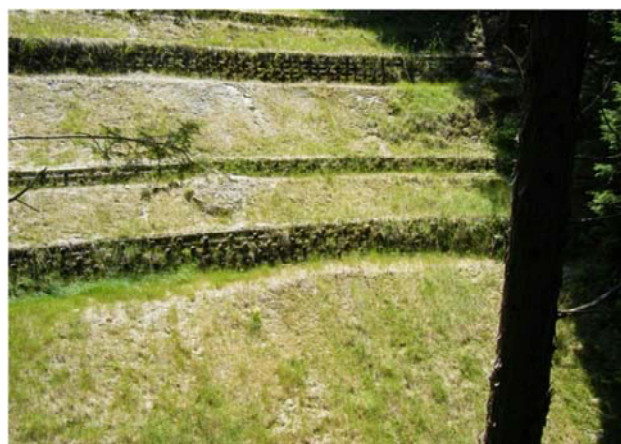
写真-5 植生が衰退した箇所
