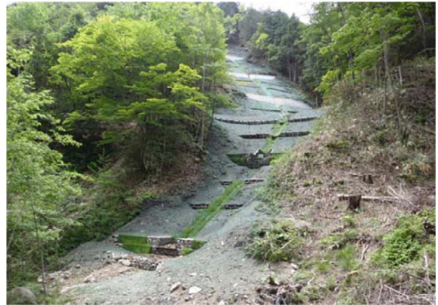
写真-6 施工後の状況（吹付実播工）
