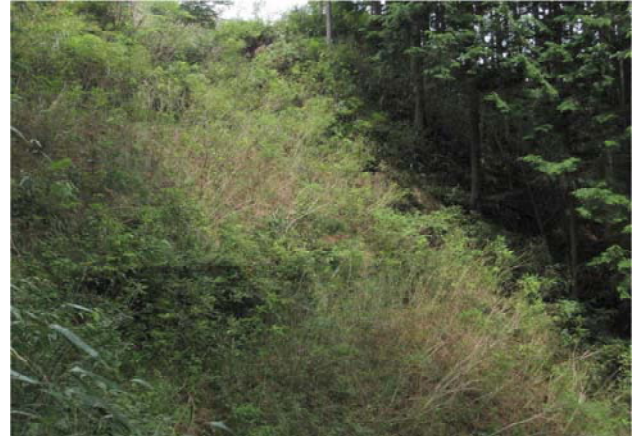
写真-16 施行5年後の生育状況 (ハニカム枠厚層基材吹付工)
