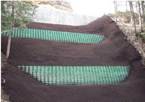
写真-15 厚層基材吹付後の状況 (ハニカム枠厚層基材吹付工)
