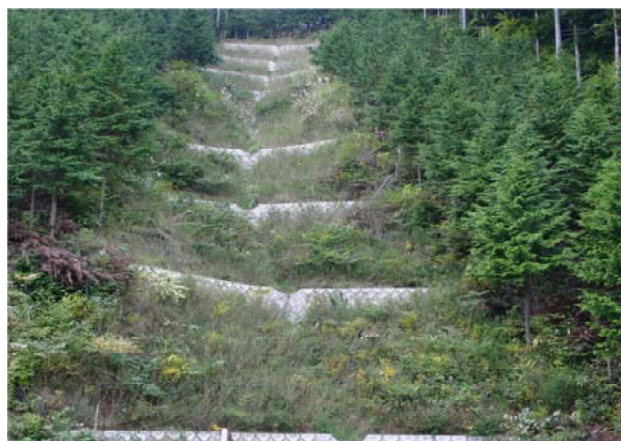
写真-3 緑化工施工箇所
