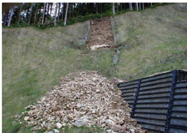
写真-4 崩落した箇所
