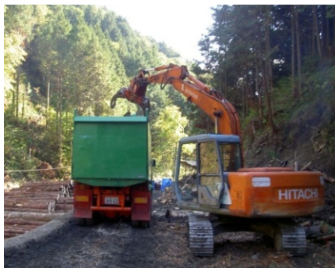
写真-8 積み込みを行う請負業者
