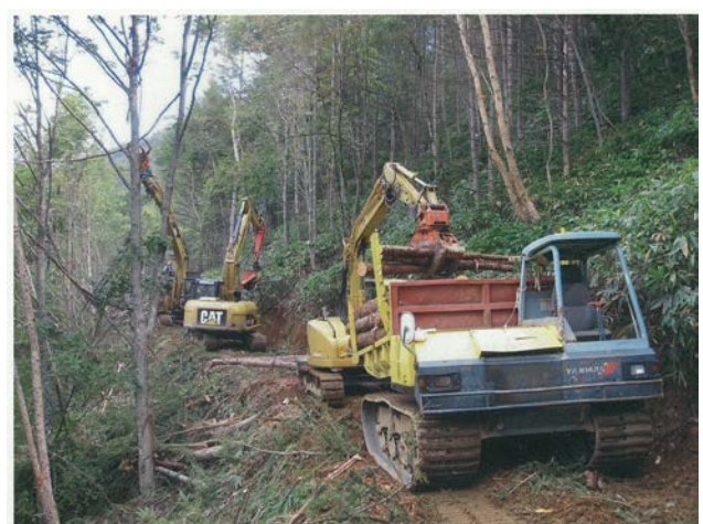
作業中の状況
