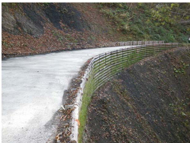
土木工事の木材使用状況
