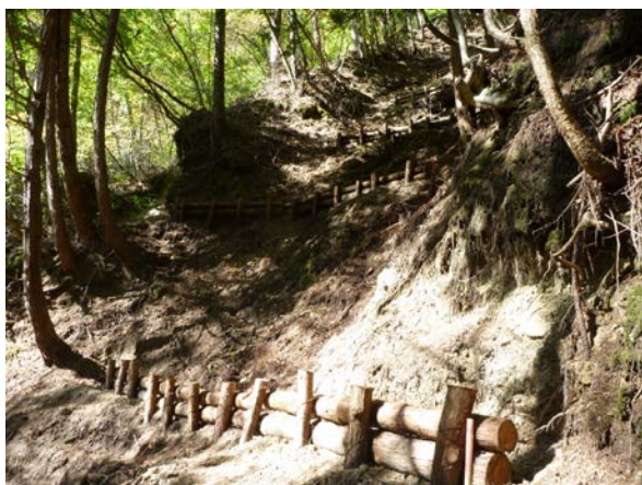
丸太筋工完成状況
