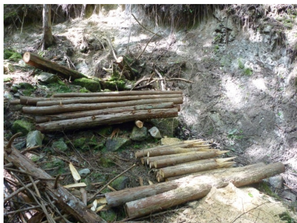
横木、杭木の作成状況
