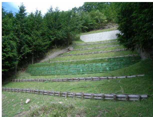
治山工事の木材使用状況
