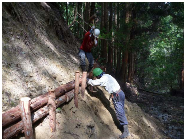
杭木の打込状況
