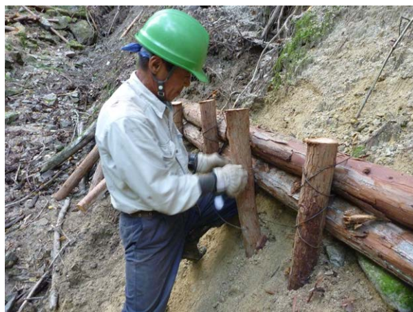
横木の固定状況
