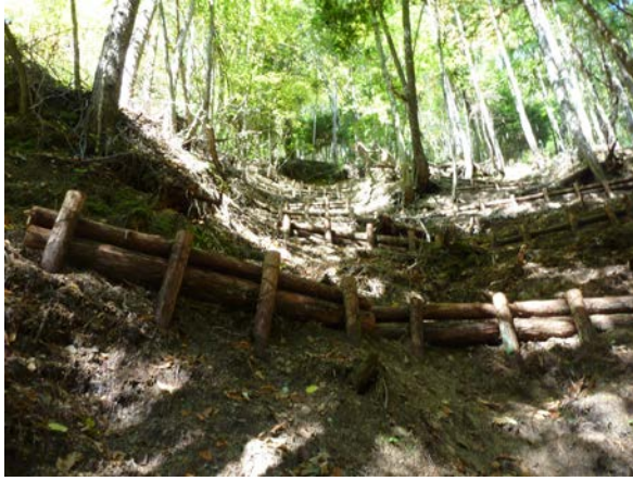
完成状況（下部）
