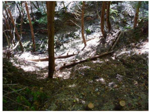
完成状況（上部）
