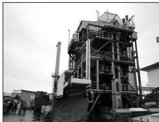
(図) 工場内の装置
