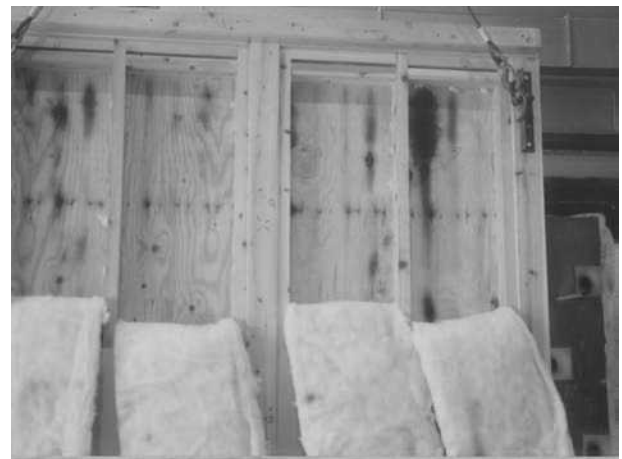
壁内部 / 壁内部へのほ炎貫通無し
