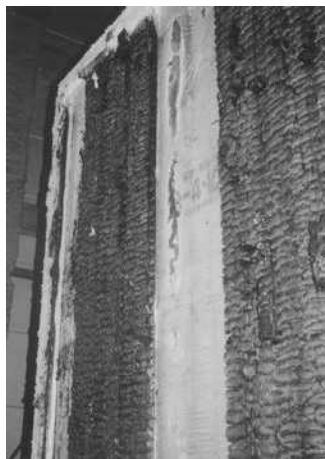
サイディング下 / 防水紙が熱で損傷
