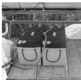
写真-3 (バッテリー)
