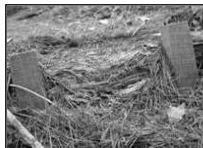
(腐朽した階段)
