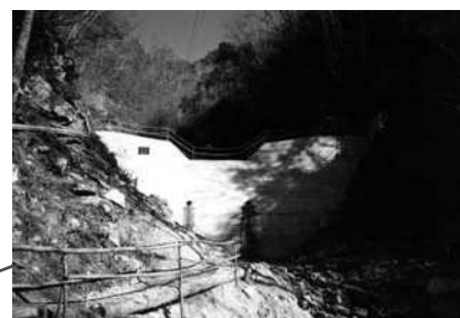
(写真 10) 溪間工設置状況
