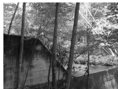
(写真 11) 堆砂状況
