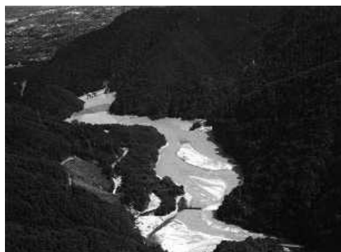
(写真 2) 松川ダム 堆砂状況
