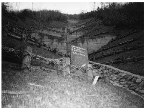
(写真 5) 平成 8 年 施工状況
