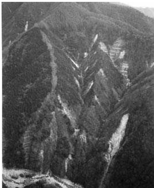
(写真 9) 溪間工設置箇所
