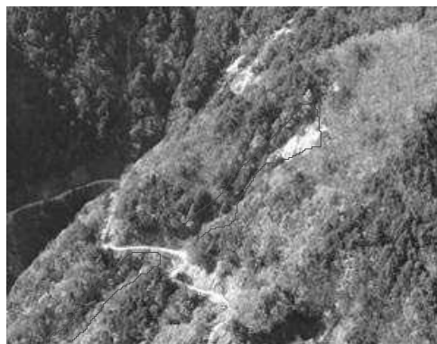
(写真 13) 治山運搬路施工状況
