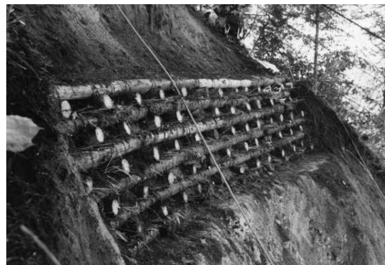
(写真 8) 間伐材を使用した丸太積土留工
