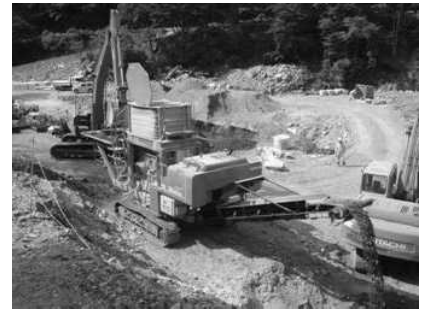
写真-5 攪拌・混合
