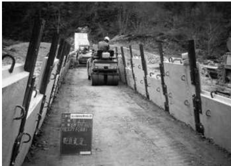
写真－10 転圧作業
