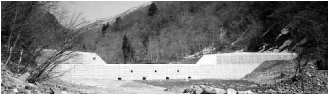
写真-14 治山ダムの完成
