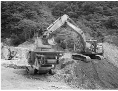
写真-3 土砂投入
