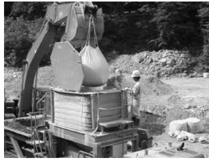
写真-4 セメント投入
