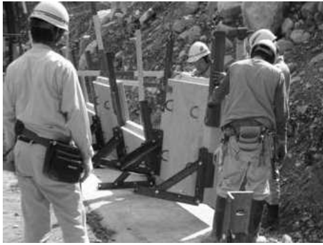
写真－8 外部保護材の設置
