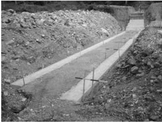
写真-12 型枠のベースコンクリート
