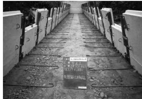
写真－11 アンカー設置
