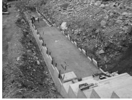
写真-13 施工中の状況
