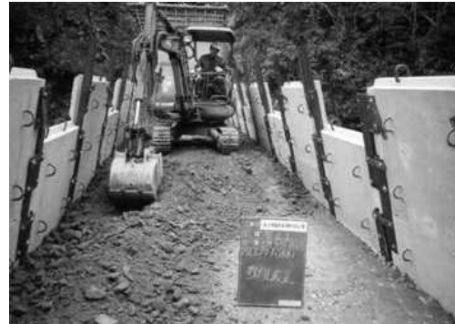
写真－9 敷均し作業
