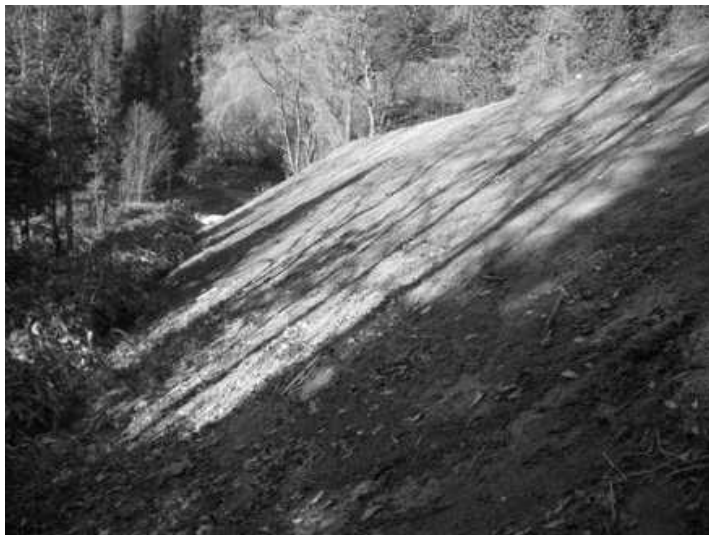
写真－1 吹付法面
