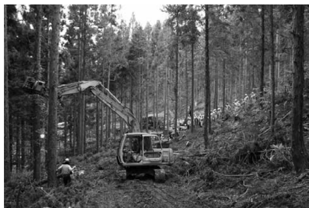
写真-13 スイングヤーダによる出材
