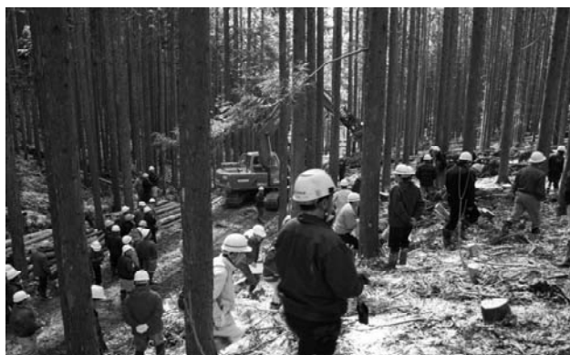
写真-19 スイングヤーダによる出材作業
