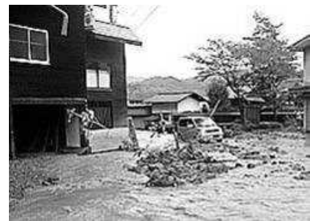
(災害による被害)
