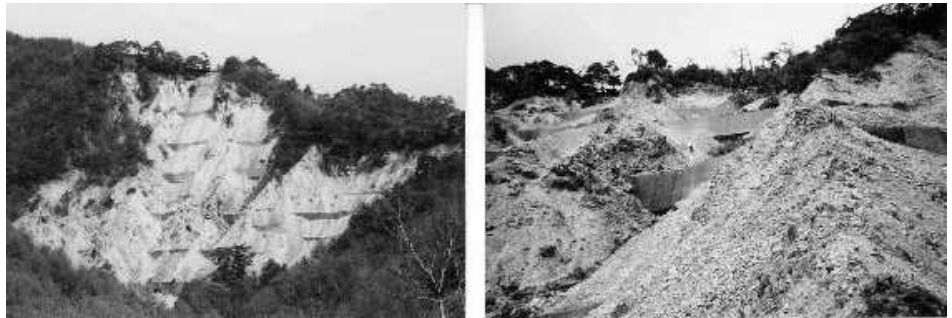
図-2 2001年崩壊地全景（左）と崩壊地内（右）
